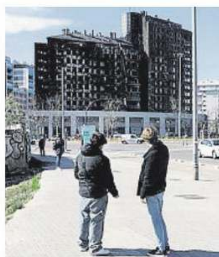
Vista del edificio incendiado
